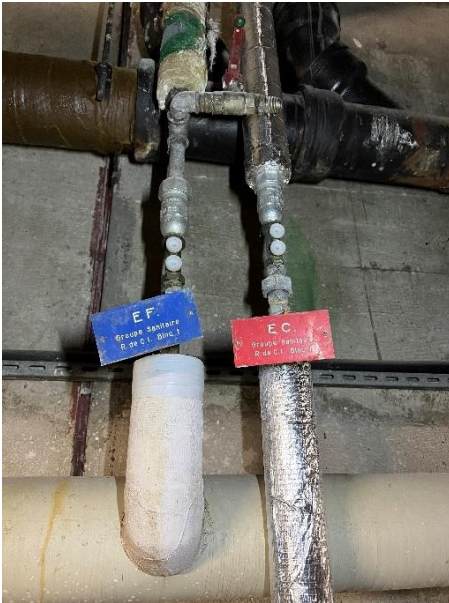
Piquage des colonnes montantes ECS/EF
