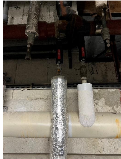
Piquage des colonnes montantes ECS/EF
