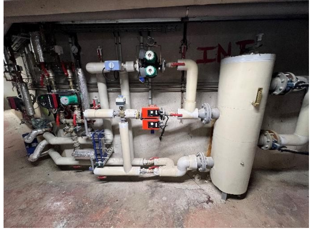
Exemple échangeur ECS
